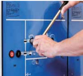
Manejo mecánico del seccionador
