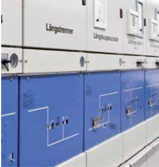
Aparamenta GMA con manómetro de presión
