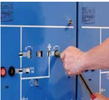
Manejo mecánico del seccionador de tierra
