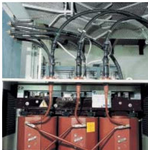
Conectores MT enchufables de 250 A y conectores separables en IP31.
