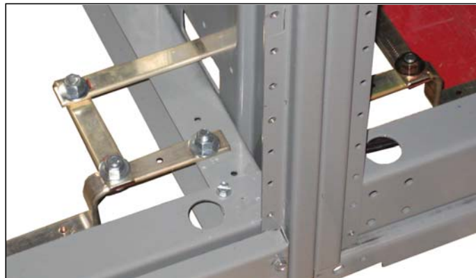
Figura 16 – Conexión de empalme de la barra de puesta a tierra de la serie 2
