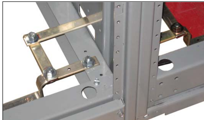
Figure 16 – Raccordement de jonction de la barre-bus de m.à.l.t. de la série 2
