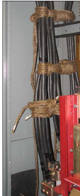
Figura 25 – Ejemplo de sujetador de cables
