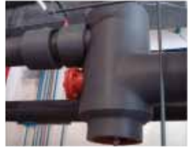
Aplicación de aislante térmico en tanques de expansión en sistema de agua helada.
