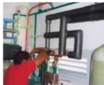
Excelente solución en aislamiento térmico para agua caliente, generada por energías renovables.
